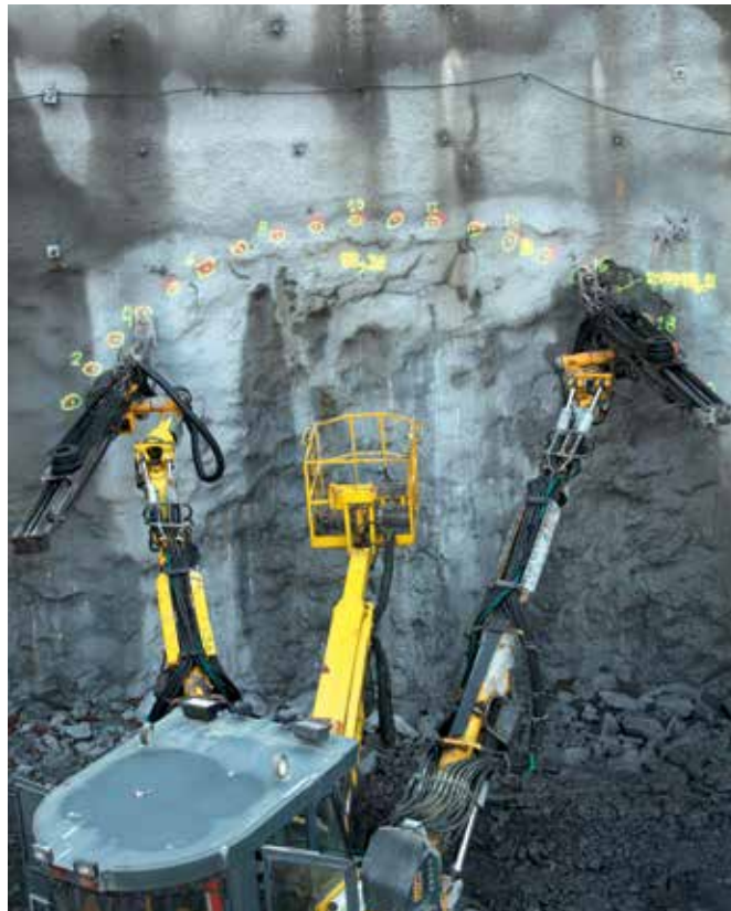
Application de voûte parapluie avec un boomer.
