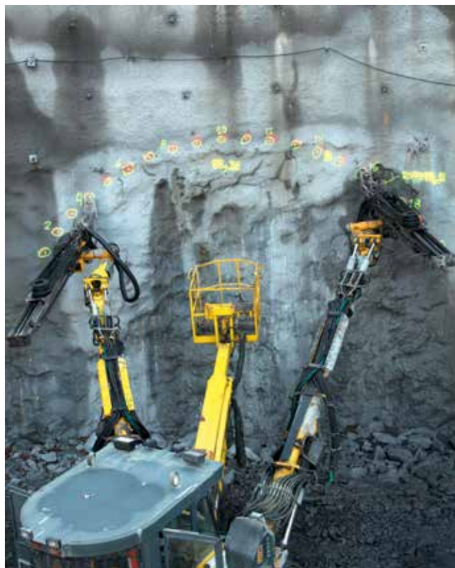
Aplicación de techo de tubería con un Boomer.
